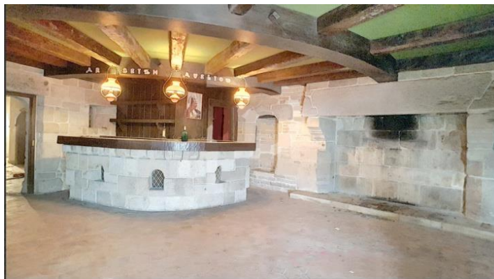
La salle du restaurant avant son aménagement
